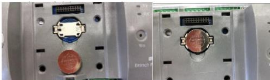
Рисунок 35 – Установка (замена) батареи
